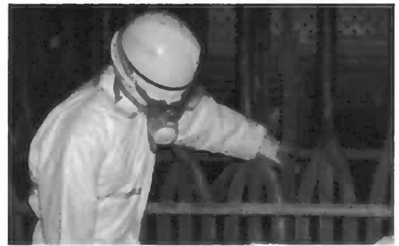
<焼却炉内の点検の様子>
