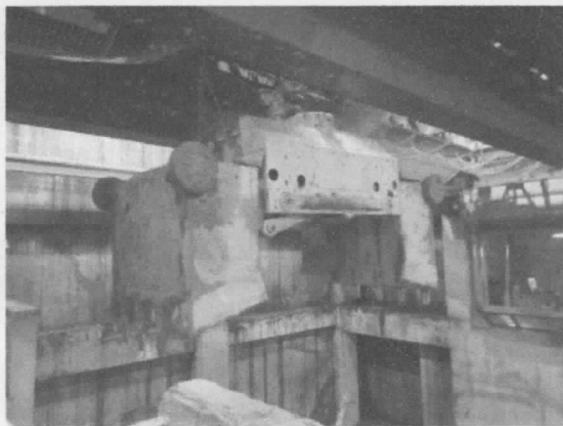
<稼働中の更新前の灰クレーン>
